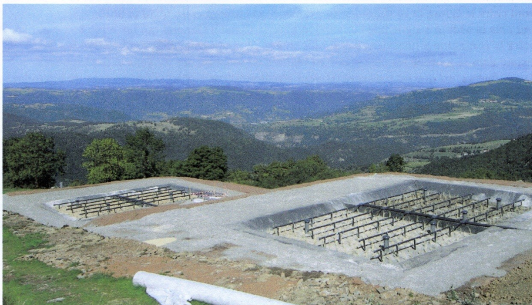
Vue de la station en cours de construction
